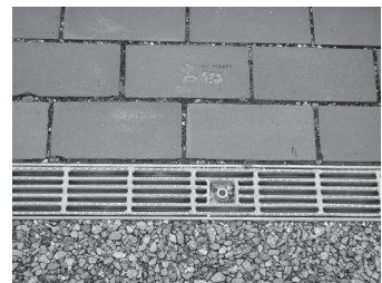
(写真5) 改修された道のディテール 上から歩道、側溝、車道
