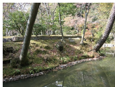
等持院庭園東池松杭護岸
