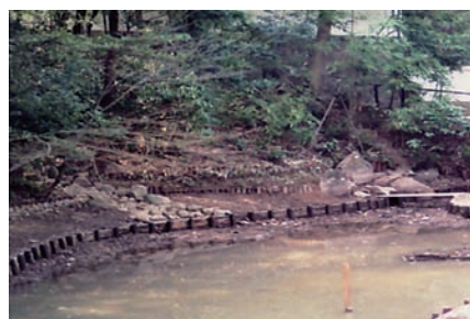
松杭護岸、竹シガラ護岸
