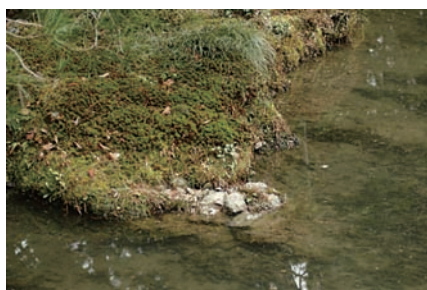
南禅院庭園西池芝止護岸
