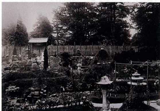
写真-17 完成写真
