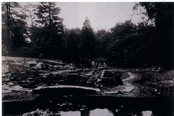
写真-14 施工中写真
