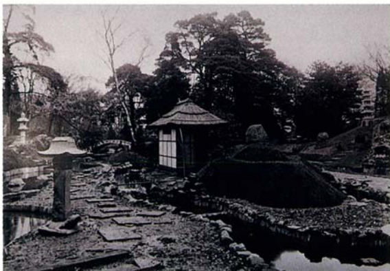
写真-15 施工中写真
