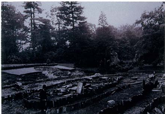
写真-13 施工中写真
