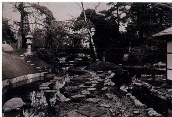
写真-16 施工中写真
