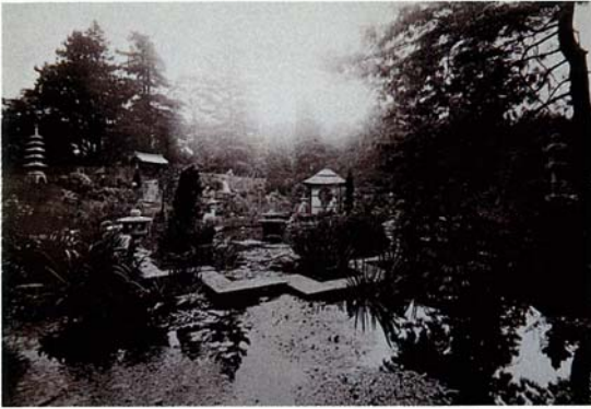
写真-29 完成後の写真
